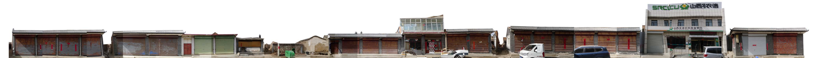
西侧沿街立面
