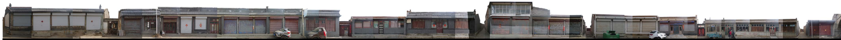
东侧沿街立面
