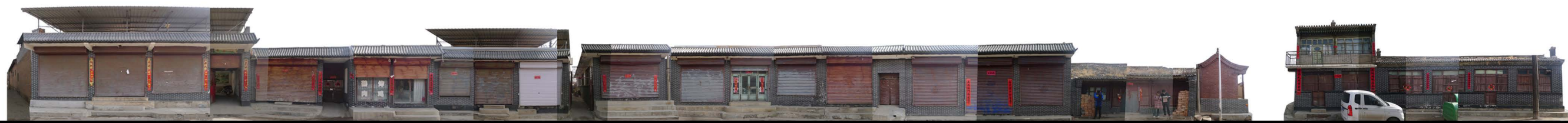
东侧沿街立面
